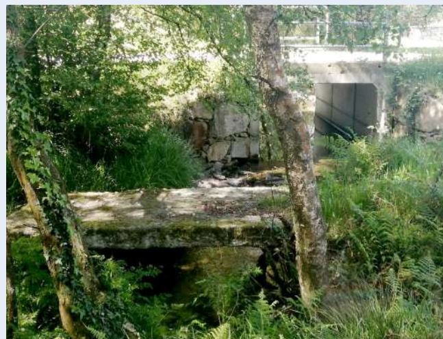
Conservación da pontella peonil de pedra existente.
