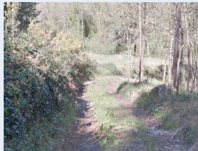
Conservación do muro existente lateral.
